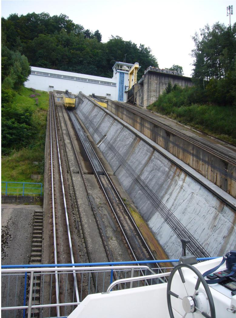
Das 1969 eröffnete Hebewerk ersetzt 17 Schleusen. Im Trog wird auf einer schiefen Ebene ein Höhenunterschied von ca. 45 m überwunden. Das spart nicht nur Zeit, es spart auch Wasser. Bei jeder normalen Schleusung fließt eine Füllung kanalabwärts. Der bergauf – bergab rollende Trog kommt ohne jeden Wasserverlust aus. Das Hebewerk ist inzwischen eine Touristenattraktion geworden.
